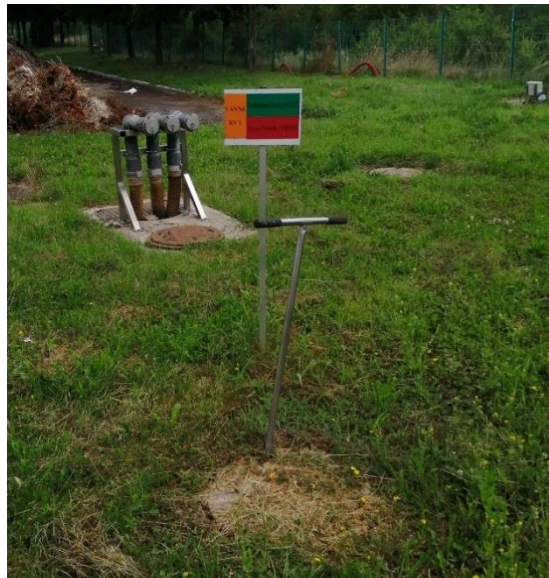
Figure 13 : Exemple de vanne d'isolement et système de pompage sur le bassin de rétention en cas d'export des eaux souillées
