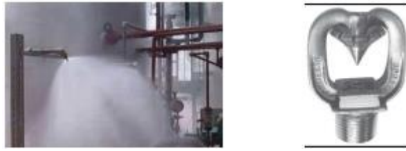
Figure 15 : Exemple de buses d'aspersion du réseau déluge
